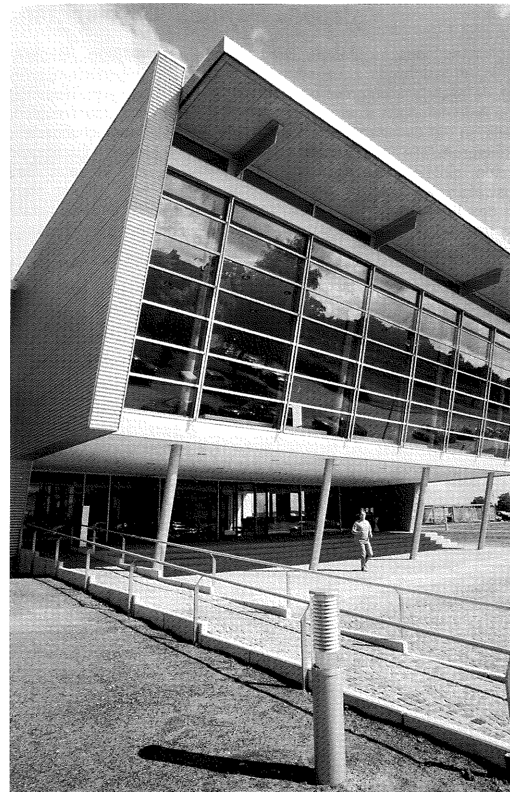
Hinter dieser Fassade verbirgt sich der Prüfungssaal des LBA..
